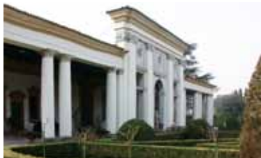
Villa Gradenigo a Oriago. Facciata della Barchessa Valmarana a Mira. Villa Gradenigo a Oriago. Facade of the Barchessa Valmarana at Mira.
