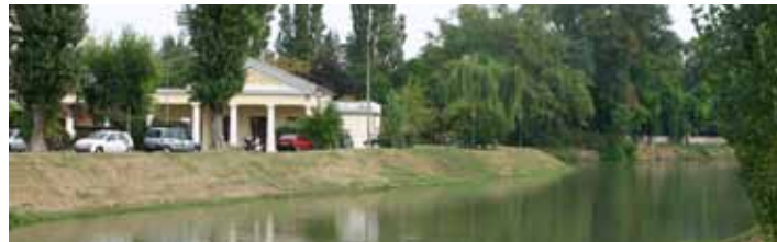
Ponte pedonale di Villa Ferretti-Angeli. Ex Macello. Footbridge at Villa Ferretti-Angeli. The old Slaughterhouse.
